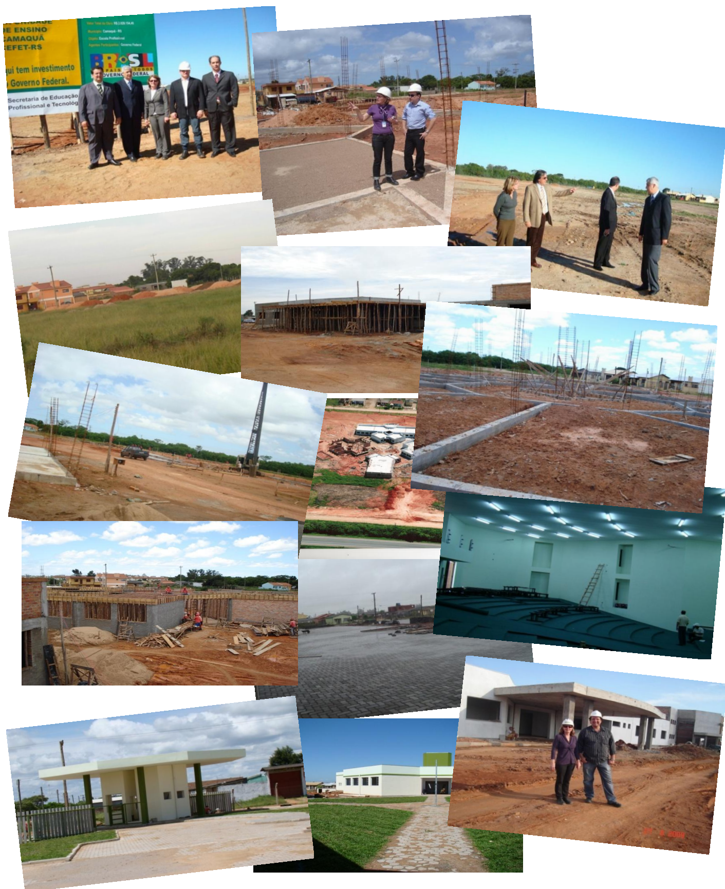
Figura 3 - Imagens das obras de construção do câmpus Camaquã.
