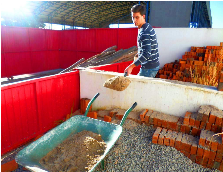
Figura 53 - Montagem da instalação no saguão do IFSUL campus Pelotas com o auxílio do estudante estagiário do curso de Edificações no transporte da areia até o local da exposição. Arquivo da autora.
