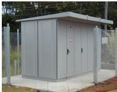
Figura 10 - Ilustração de cabine primária para transformadores
