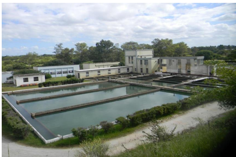
Figura 21: Estação de Tratamento de Água Santa Bárbara, Pelotas, Rio Grande do Sul.
