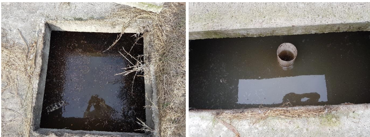
Figura 9 – Efluente da fossa (esquerda) e filtro biológico (direita)
