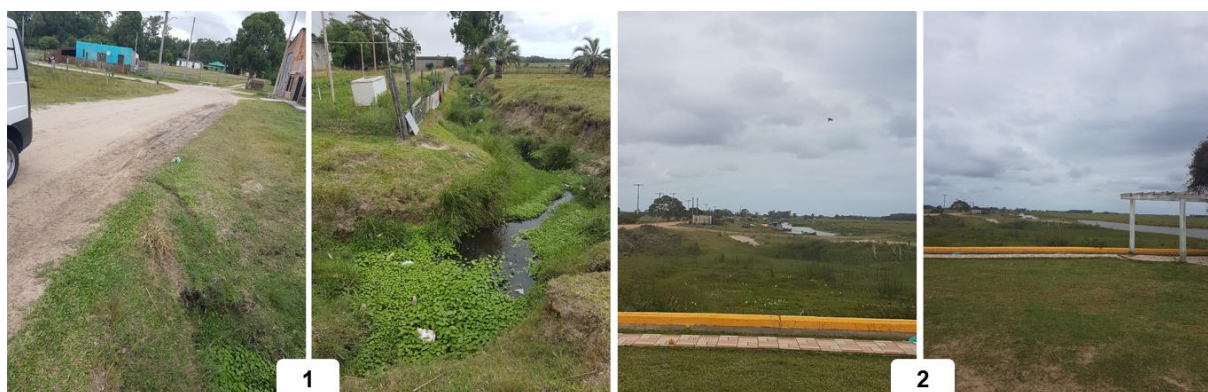
Figura 20 – Imagens do canal de drenagem pluvial nos pontos 1 e 2 demarcados na Figura 19
